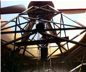
Ventiladores en torres de enfriamiento de tiro inducido en la parte superior de la TE con acoplamiento y reductor.
