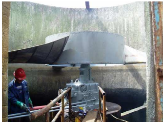
Ventiladores en torres de enfriamiento de tiro inducido en la parte superior de la TE con reductor y eje cardan.
